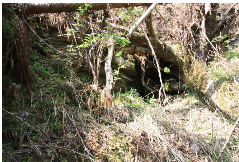
Obr. 9 Neprůchodný vchod do Dřevěné štoly
